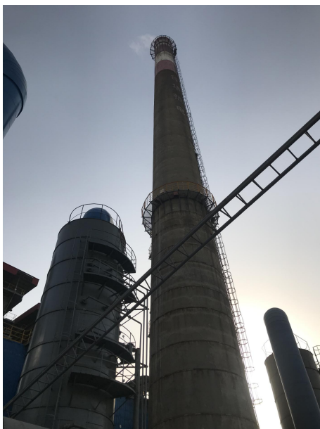
图 4-5 80m 高排气筒照片
